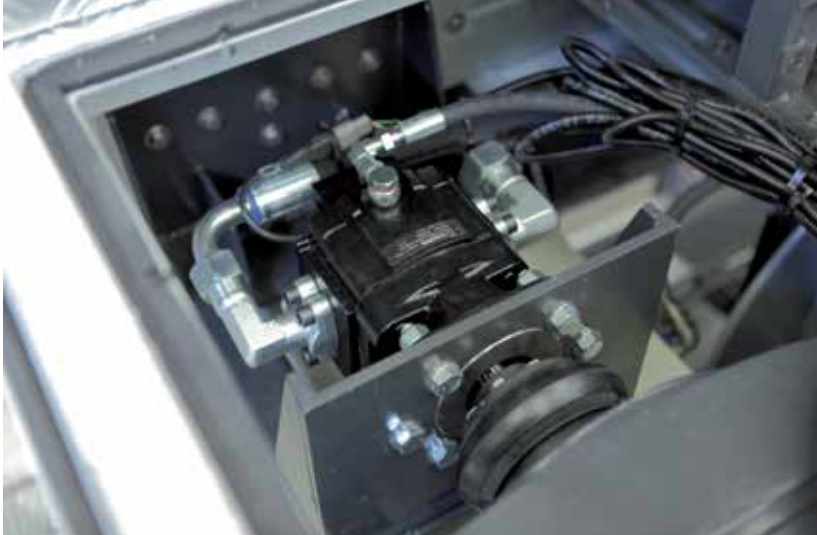
Motore oleoidraulico a cilindrata fissa Casappa, equipaggiato con sensore di velocità e una pompa a pistoni a cilindrata variabile con controllo elettronico della cilindrata.
